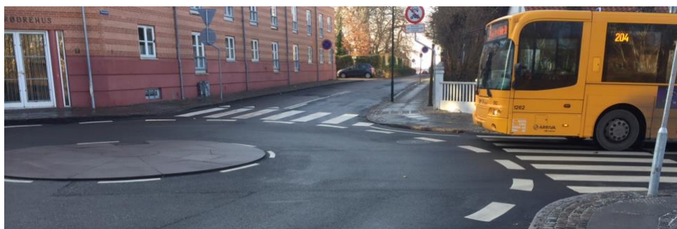
FIGUR 6. MINIRUNDKØRSEL VED DR. MARGRETHESVEJ – SCT. OLSGADE. DETTE TILTAG HAR FORBEDRET FREMKOMMELIGHEDEN OG SIKKERHEDEN I KRYDSET.
